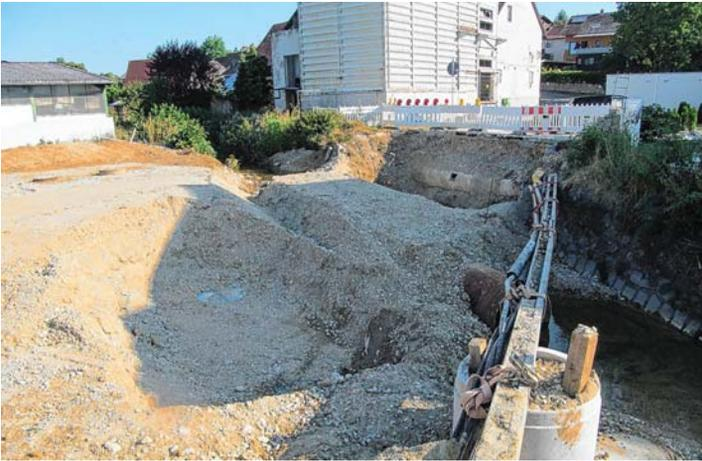
**Die Arbeiten** bei der Hochwasserschutzmaßnahme Neuhäusen gehen auch während der Sommerferien voran. Bei der Brücke im Mühlenweg sind die erforderliche Kanalumlegung und die Pfahlgründungen erfolgt, der Brückenaufbau schließt sich nun an.
